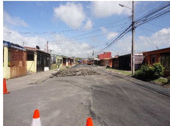
Imagen 4 Trabajos de conservación vial en Los Sitios
