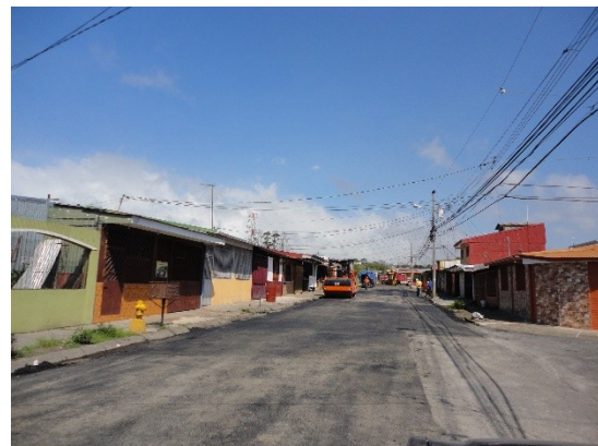
Imagen 5 Colocación de mezcla asfáltica en caliente en los Sitios
