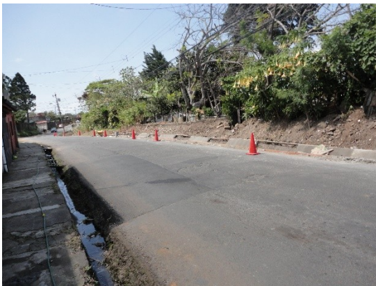
Imagen 2 Avance en los trabajos de canalización de la Isla
