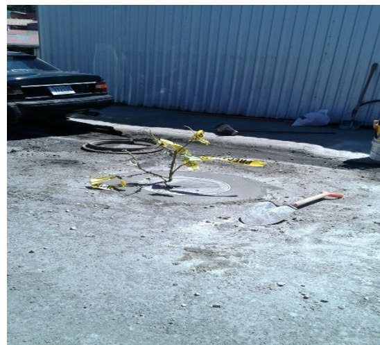
Imagen 6 Reposición de tapa de alcantarillado pluvial en La Fabiola
